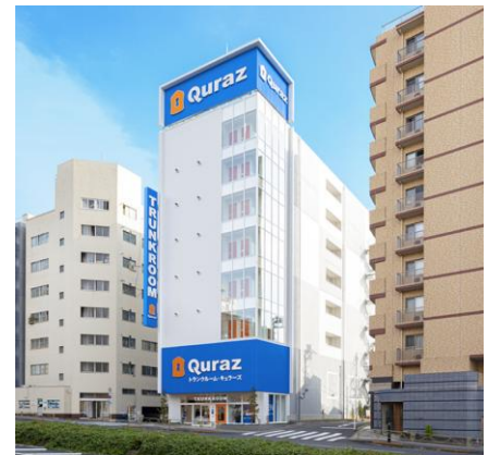
ビル一棟丸ごとトランクルーム
